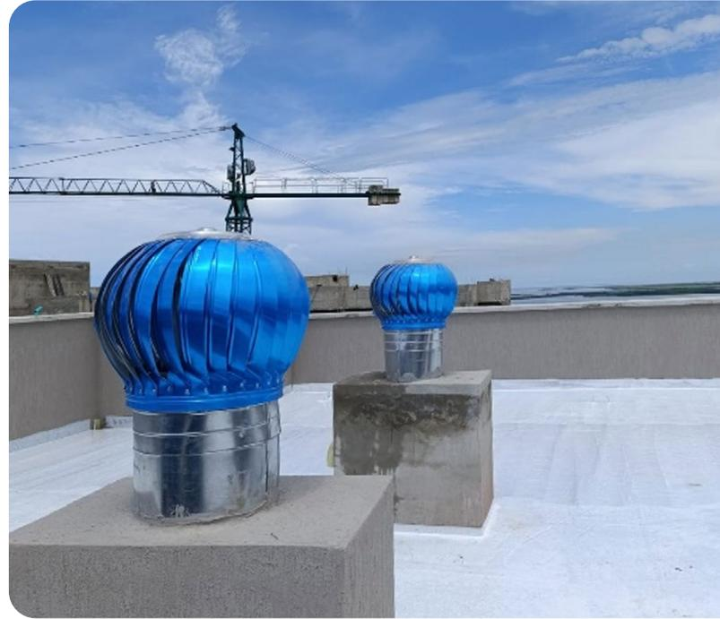
Cada torre cuenta con sistema de extracción eólica (sistema de ventilación mecánica), la cual garantiza la succión de gases acumulados y permite el ingreso de aire fresco de manera natural, manteniendo un nivel constante de aire en el ducto. La capacidad máxima del sistema está dada en función del caudal de ingreso y caudal de salida en las torres.
