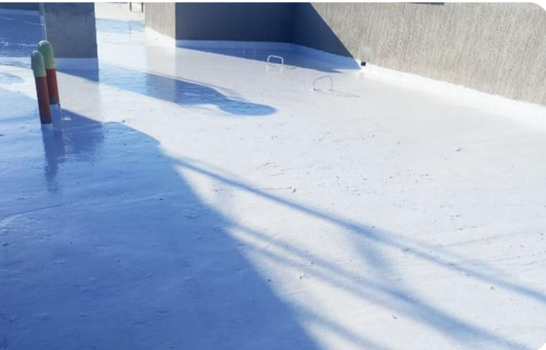
Las cubiertas cuentan con un sistema impermeabilizante el cual las protege de las filtraciones, fisuras y otros fenómenos meteorológicos, con ellos garantizamos la durabilidad y resistencia de los elementos estructurales.
