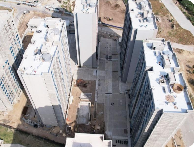
La cubierta de las torres está compuesta por una placa de concreto, con una resistencia de 4000 PSI. Posteriormente, se hizo un alistado en mortero de 2500 PSI que garantizará la pendiente adecuada para descargar las aguas lluvias que recibe la cubierta hacia las bajantes.
